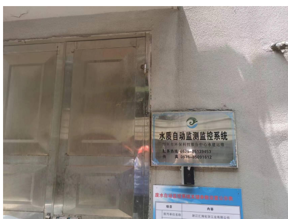
废水在线监控及污水计量房
