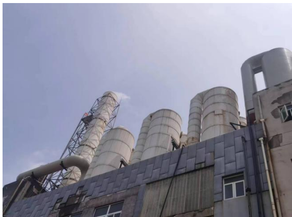
氯化车间废气装置
