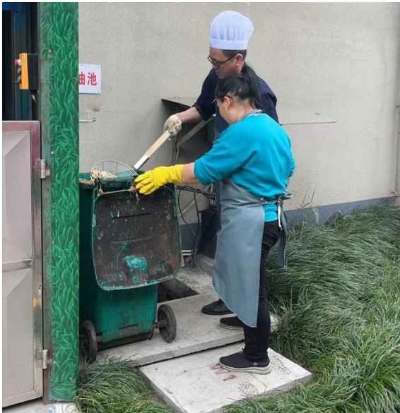
隔油池、化粪池清理照片
