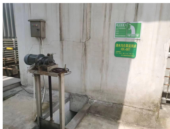
厂区北侧雨排口 DW002
