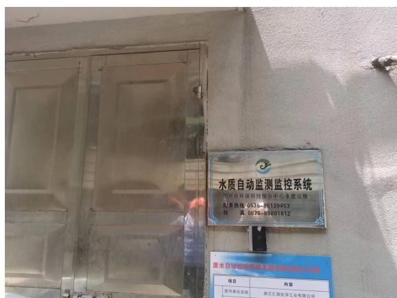
废水在线监控及污水计量房
